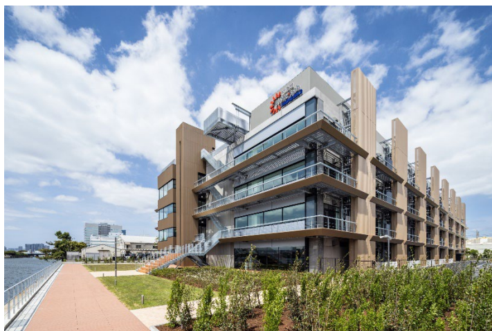
「三井リンクラボ新木場 2」外観(南東側)
