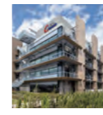
三井リンクラボ新木場2
